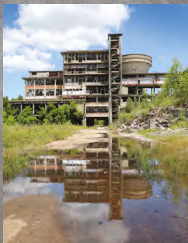
L'ancien lavoir à charbon Blaye-les-Mines
